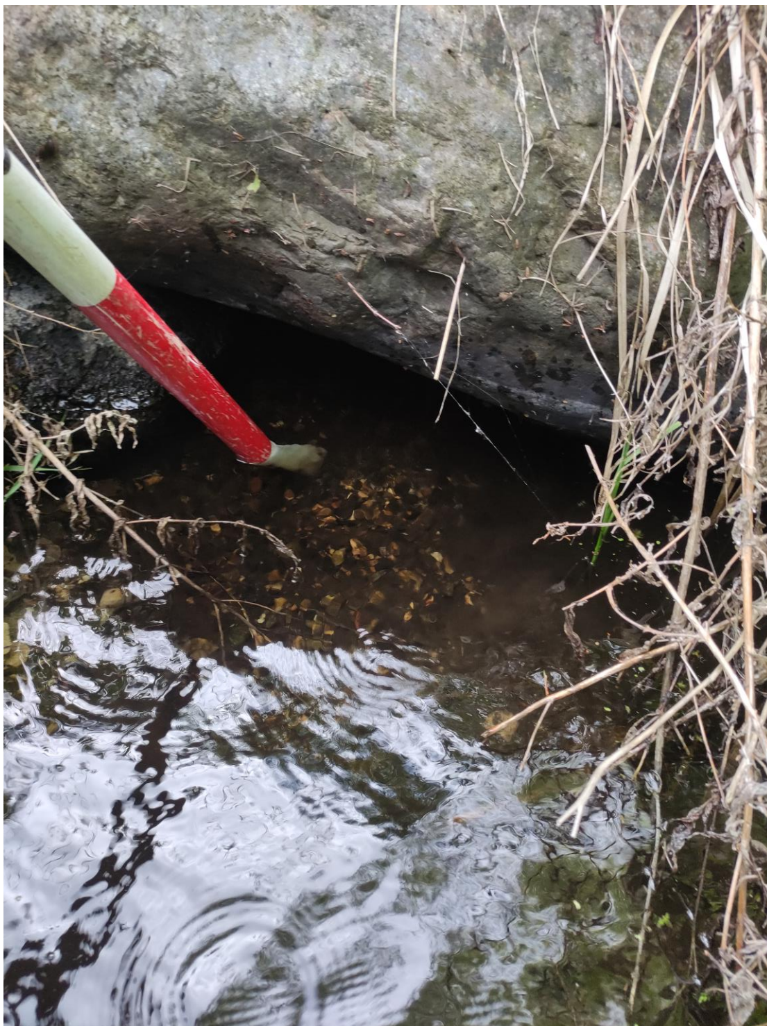
Figur 13 Station 1010. Rørud skult under sten. Dimension usikker.
