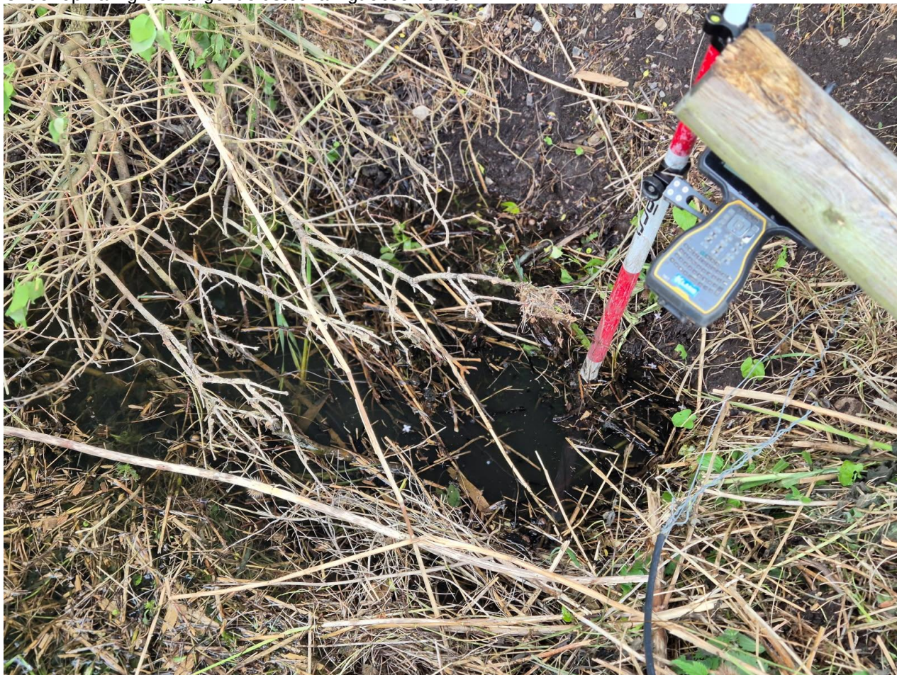
Figur 3 Station 65 Rørindløb kunne ikke lokaliseres.
